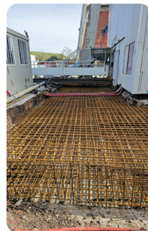
> Ferrillage des fondations.
