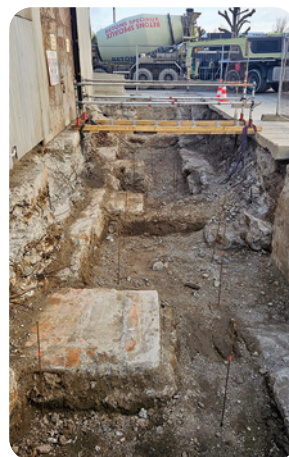
> Terrassements avant fondations.
