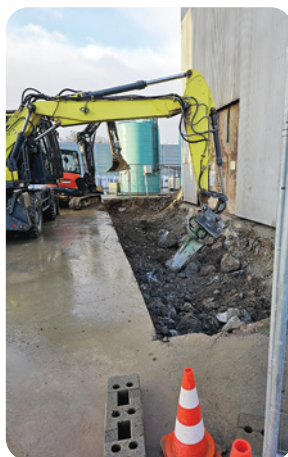
> Piquage des fondations du faux carré.
