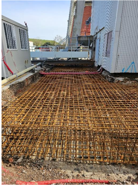
Le ferrailage du radier béton sur 1 m d'épaisseur défini par un bureau d'étude en structure
