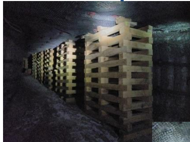
Piles fixes en bois
