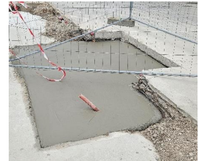
Fondation de l'exostructure
