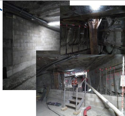
Remplissage au coulis (370 m3)
