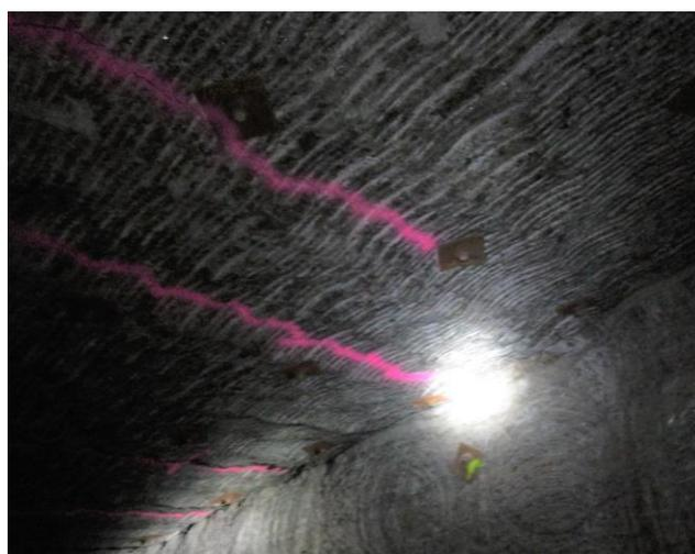
Figure 10 : Espacement des fissures en voûtes matérialisé par peinture rose
