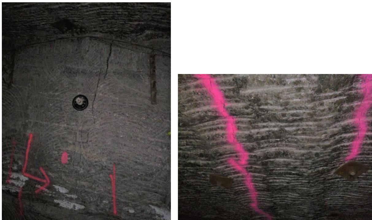
Figure 9 : Fissures annulaires en piédroit et en voûte
