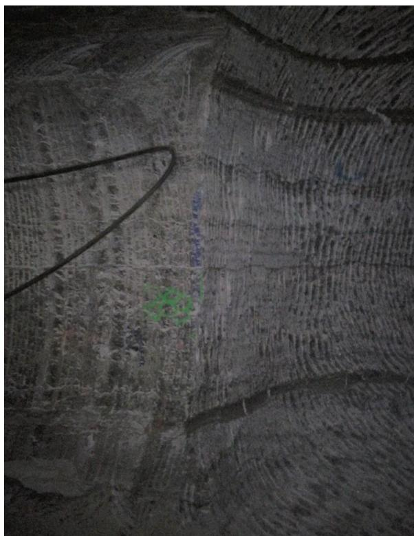
Figure 4 : Angle saillant résultant du réalésage plus important dans la zone de béton coulé (partie droite)
