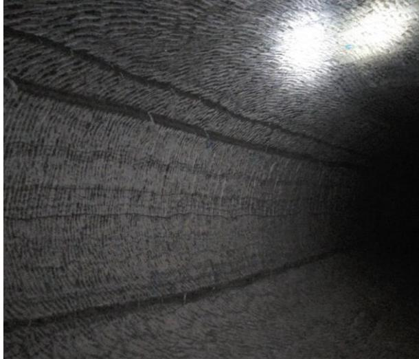
Figure 5 : Zone de réalésage pour mise en place du béton coulé
