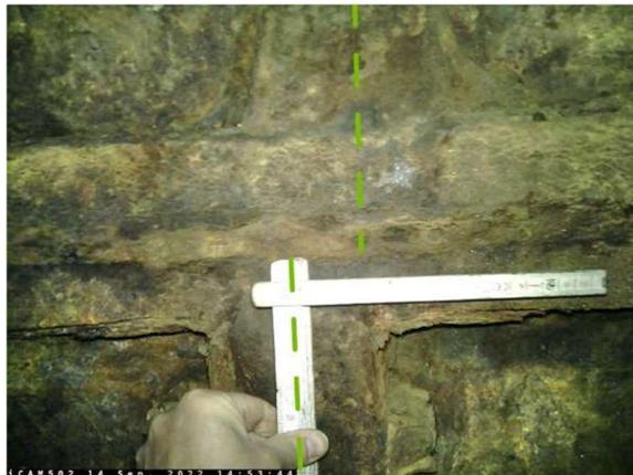
**Figure 115. Déplacement vertical des segments de cuvelage jusqu'à environ 40 mm.**
