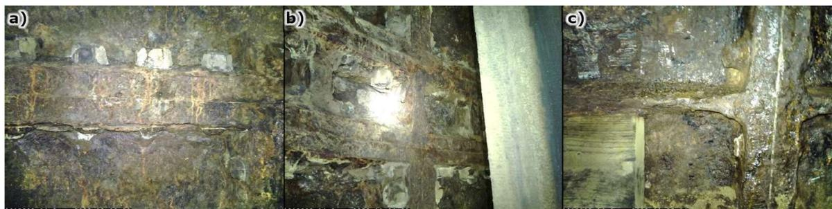
**Figure 116. Corrosion des plaques en fonte**
