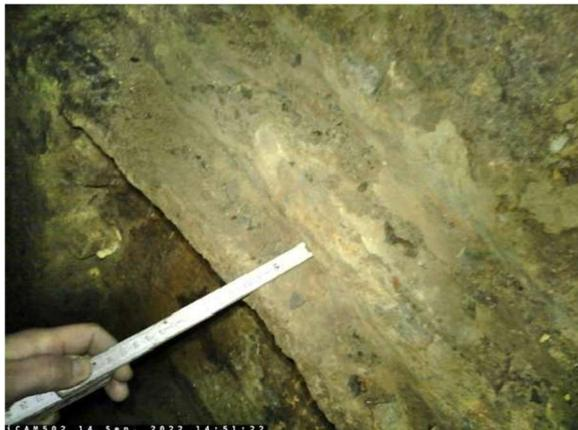
**Figure 114. Déplacement horizontal des segments de cuvelage jusqu'à 60 mm**
