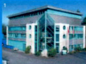
3 Bref aperçu de l'installation
