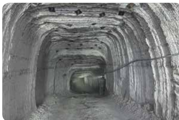
Le boulonnage du toit
