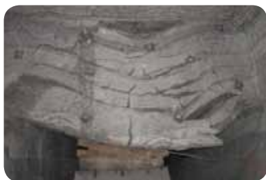
Le rétrécissement des galeries et les mouvements de terrains
