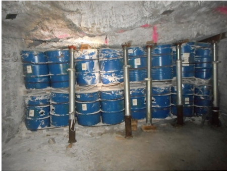
Exemple de fûts coincés et de pose d'étauçons (piliers métalliques)
