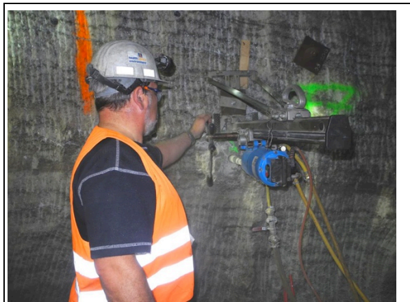
Photo 25 : opérateur réalisant une mesure de contraintes
