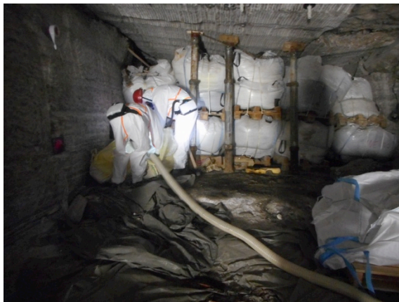
Photos 14 : opérations d'aspiration d'un big-bag
