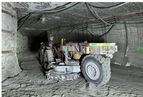
Photo 4 : rabasseneuse aplanissant le sol
