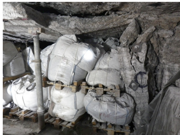
Photo 26 : allée 1 du bloc 12
