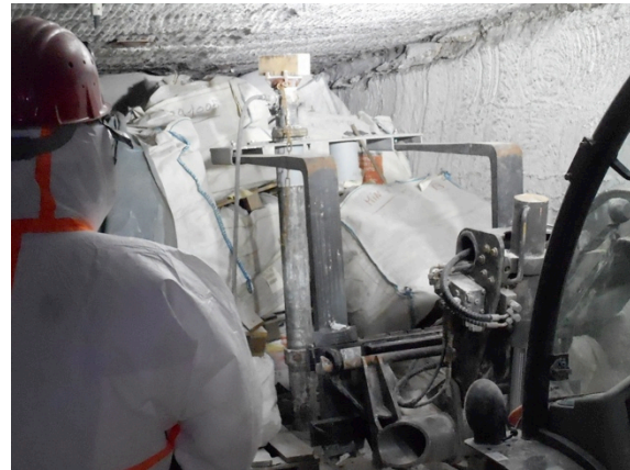
Photo 13 : pose d'un étaçon
