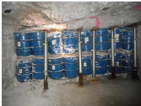
Photos 23 : big-bags et fûts coincés par soulèvement du mur
