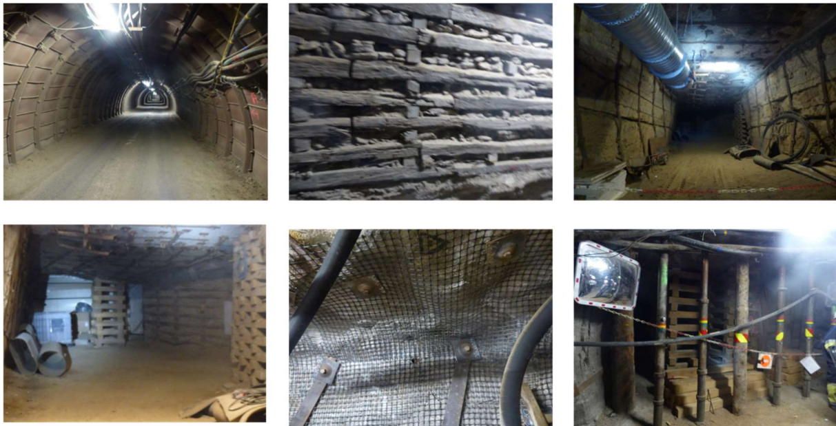
Figure 12 - Variété de soutènements observés dans la mine
