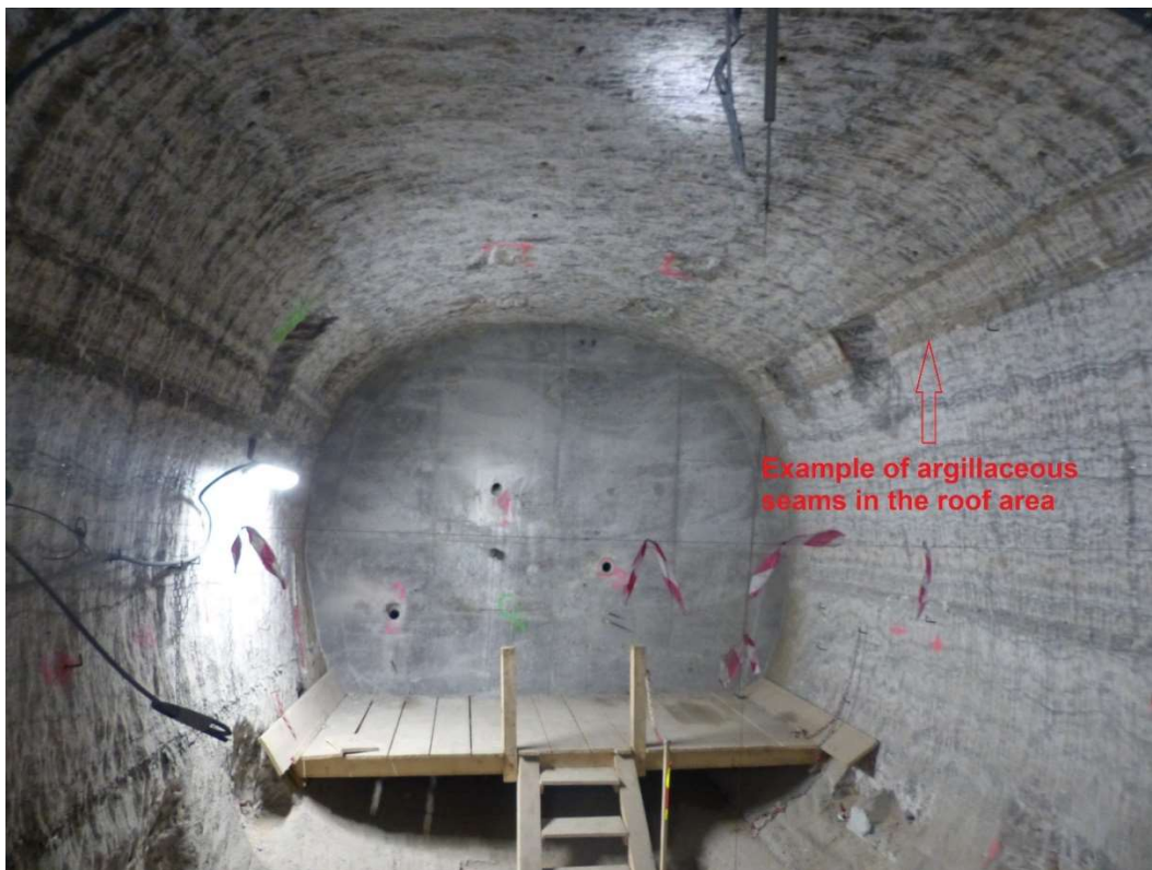
Figure 14 - Lits argileux en toit au niveau -23m
