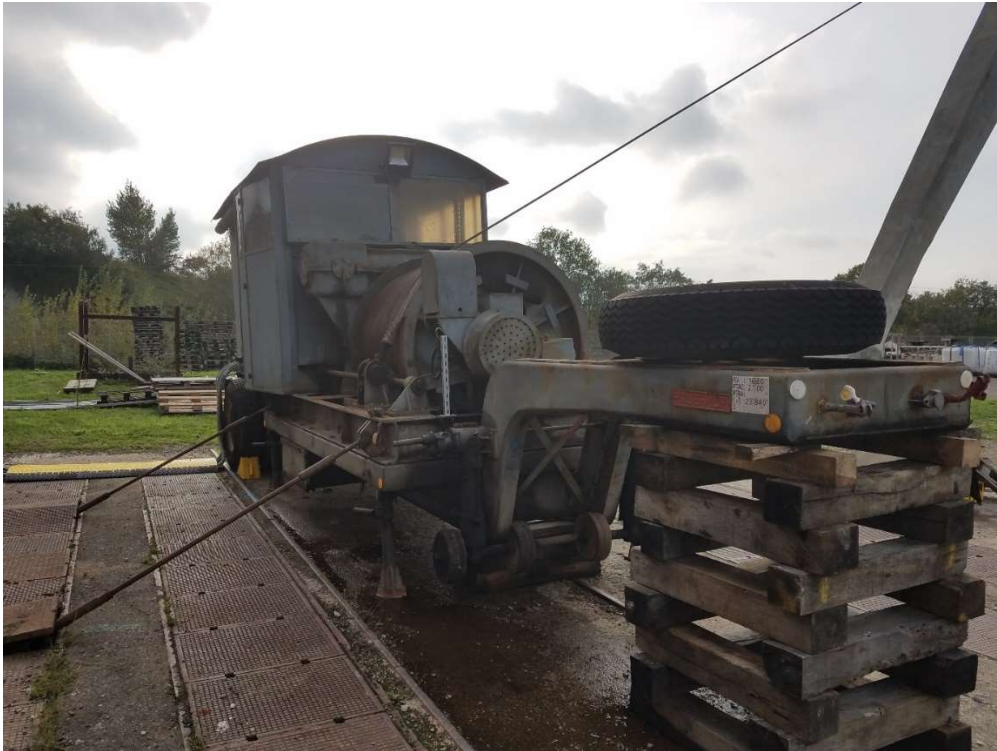
Figure 4 - Treuil de secours du puits Else
