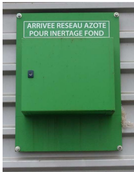
Figure 37 - Branchement extérieur en surface
