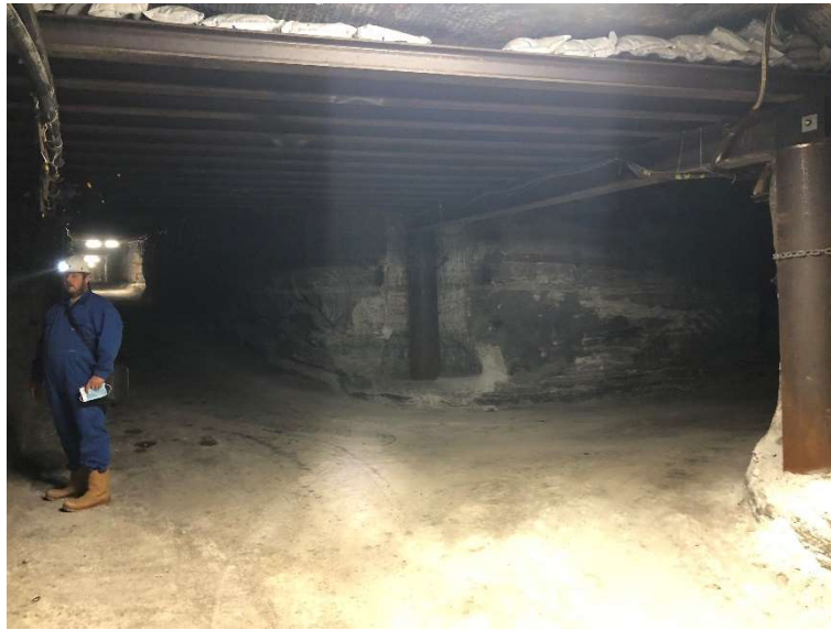
Figure 13 - Exemple de soutènement très lourd au carrefour entre les voies AQ1 et AJ1
