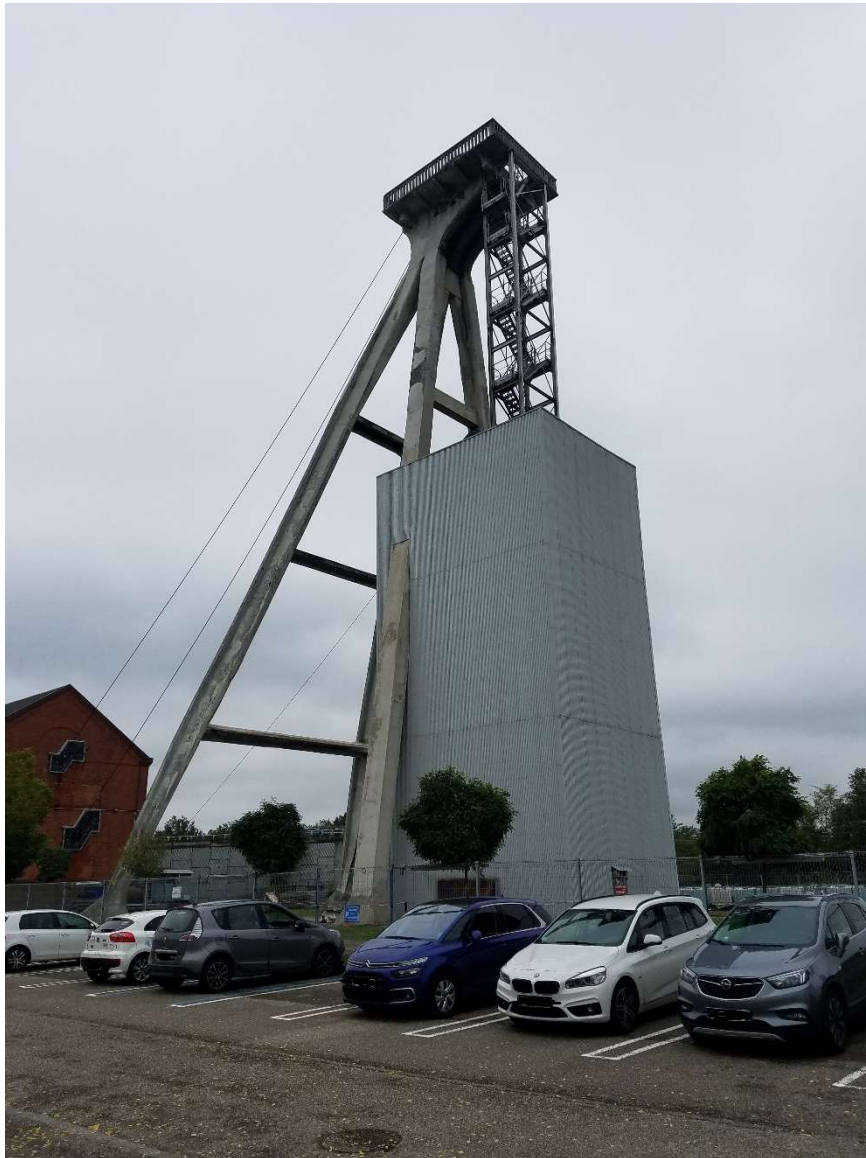
Figure 6 - Chevalement du puits Else constitué de piliers en béton armé.
