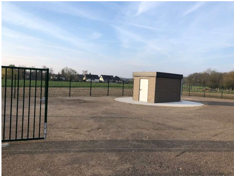
Vue d'un exemple de plateforme clôturée, avec exemple de local technique (VLPB2).
