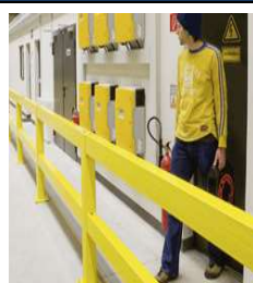
Séparation par garde-corps des zones de circulation
