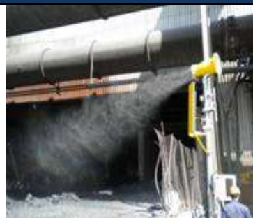
Brumiser les zones en cours de travaux
