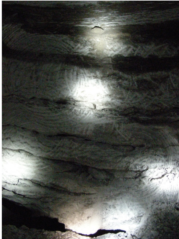
Vue des terrains qui séparent les toits « -25 m » et « -23 m »
