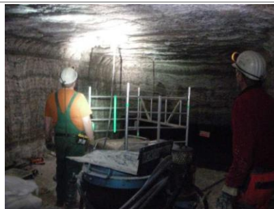
L'injection du sondage W3
