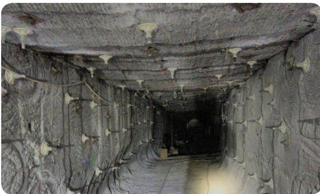
> Boulonnage de sécurité dans la zone du barrage 3.
