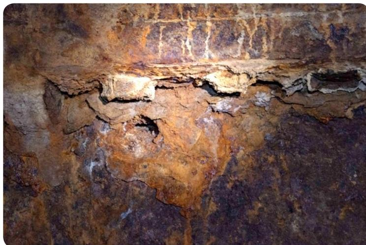
> **Corrosion très avancée du cuvelage du puits Joseph.**
