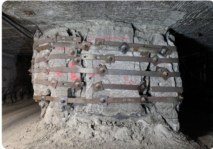
> **Pilier de la voie centrale renforcé, fracturé. Une des deux voies devra être condamnée par bétonnage afin de soulager les contraintes dans le pilier.**
