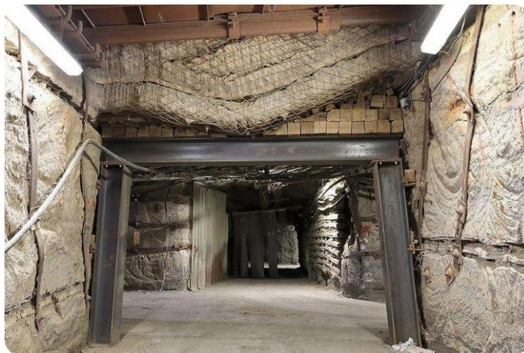
> **Contour du puits Joseph : renforcement du toit affaissé au niveau d'une carrure.**
