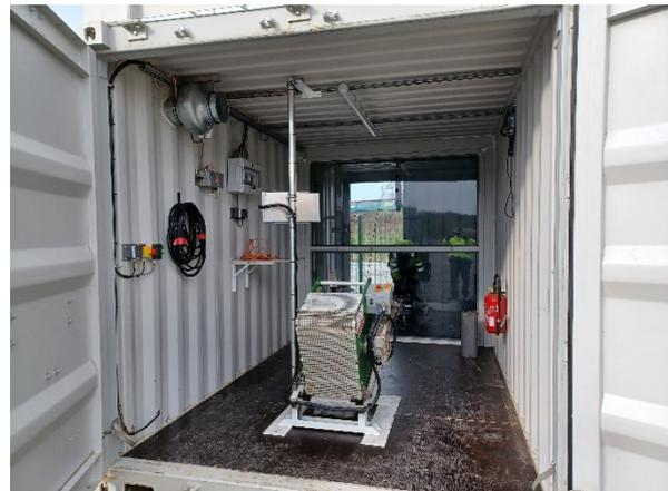
Photo 2. Vue des compartiments ATEX (à gauche) et non-ATEX (à droite) du container du VA-PB2
