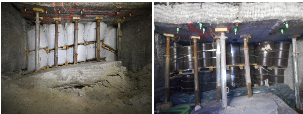
Illustration 4 : Soufflage du radier et colis au contact du toit au niveau du bloc B12 lors des opérations de déstockage en 2016 (photos MDP)
