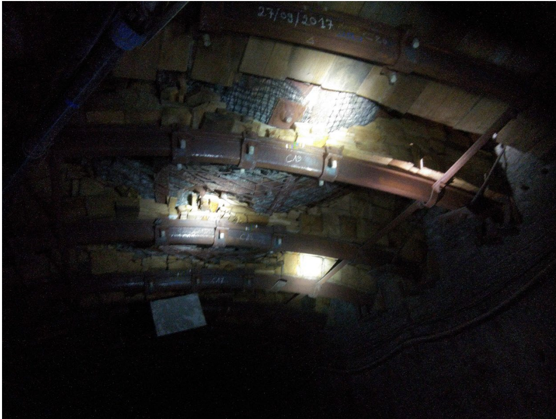
Illustration 7 : Cintres coulissants dans la zone centrale du stockage – inspection du 10 février 2023
