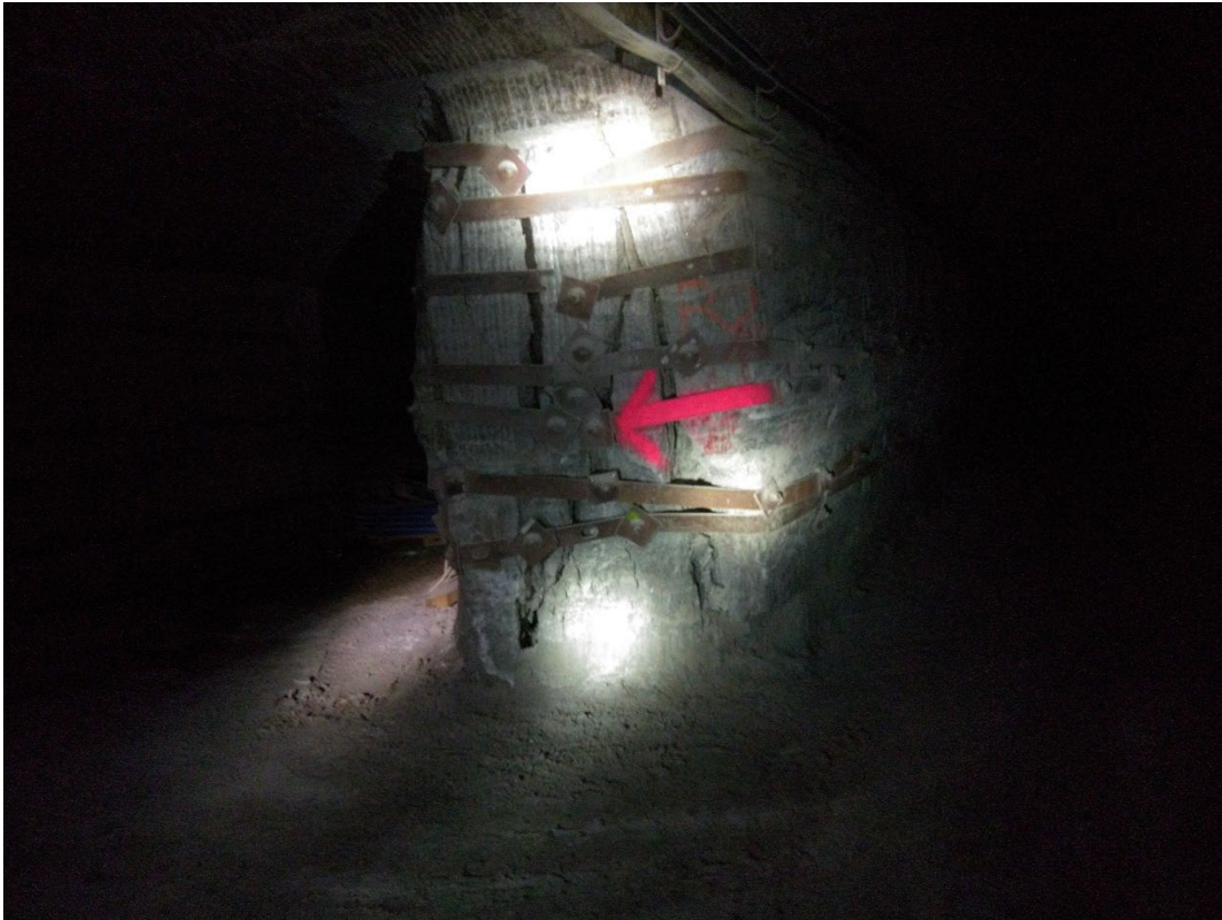
Illustration 9 : Exemple de fracturation de pilier observée lors de la visite du 10 février 2023
