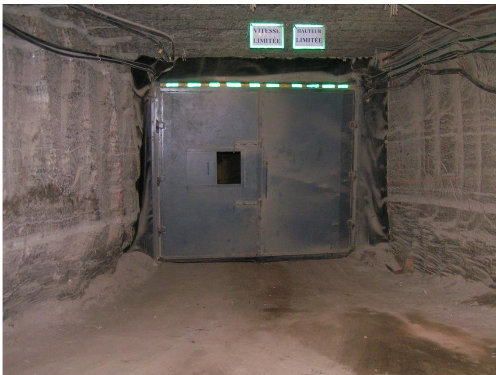
Figure 20 : Porte coupe-feu métallique
