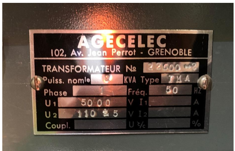
Figure 11 : HTA - Cellule n°3 - Transformateur 5kV-110V - Plaque signalétique
