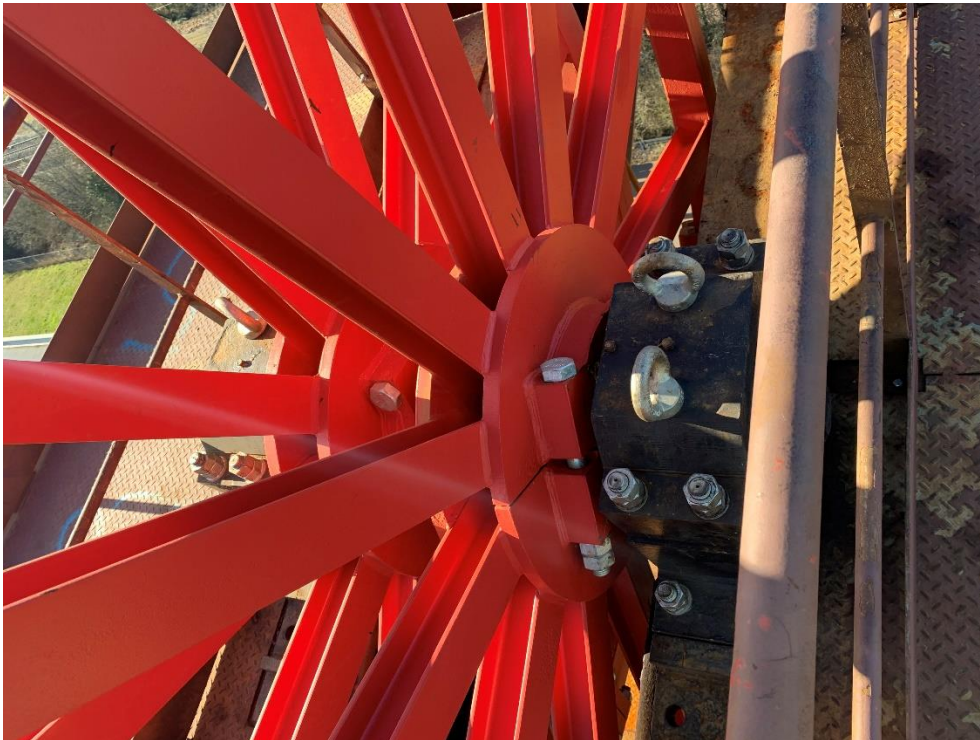
Figure 14 : Molette supérieure Joseph - Paliers
