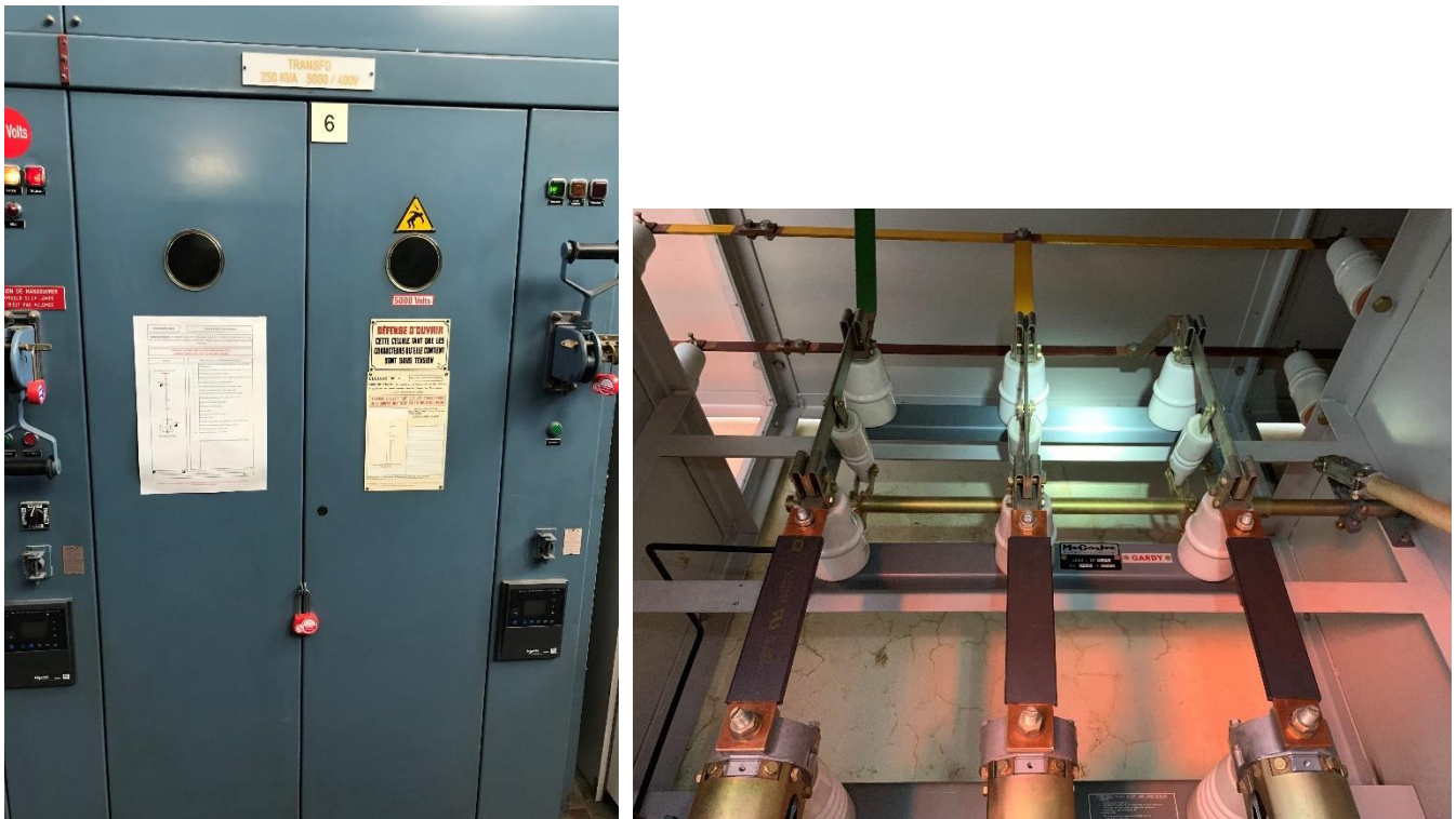
Figure 8 : HTA - Cellule n°6 - 5kV-400V TNS - Vue façade et intérieur haut
