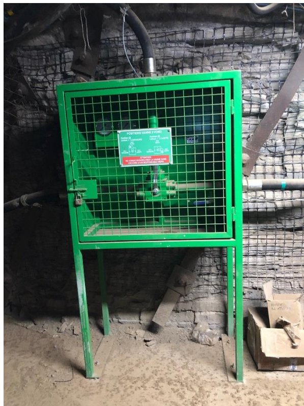
Figure 18 : Tableau de distribution réseau azote fond
