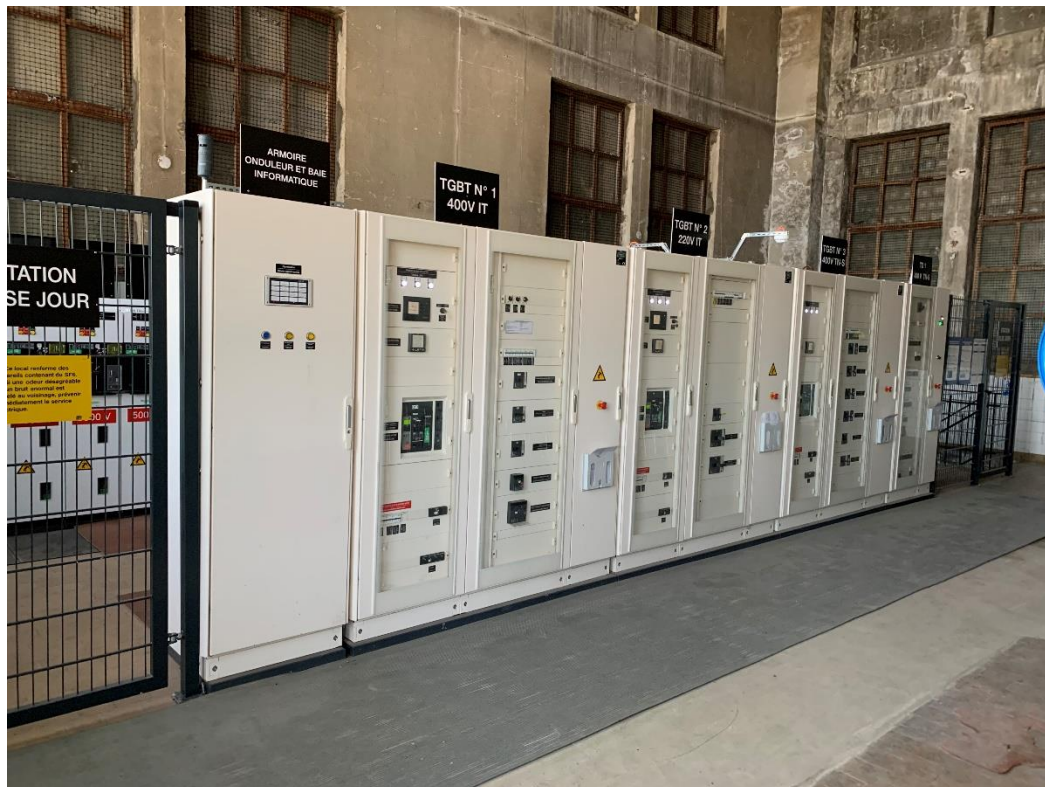
Figure 32 : Station électrique - Vue générale extérieure (TGBT et Onduleur et baie informatique)
