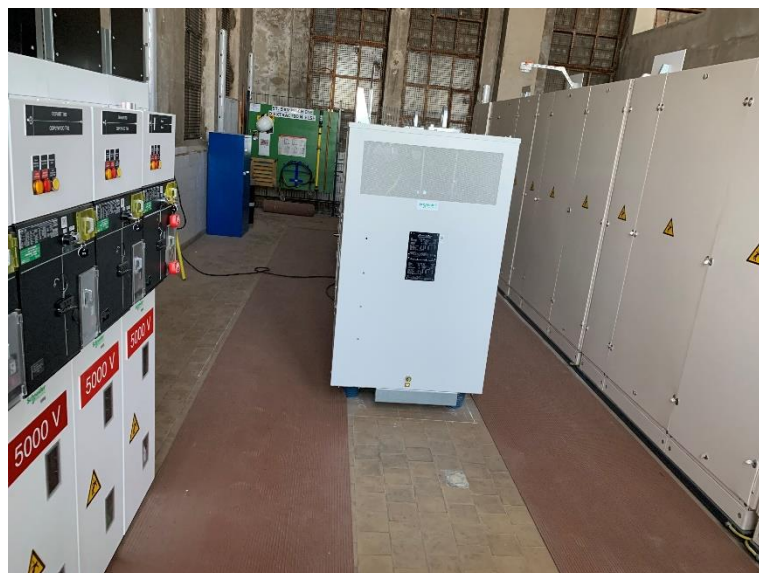
Figure 33 : Station électrique - Vue générale intérieure (Poste HT à gauche, transformateurs au centre, TGBT à droite)
