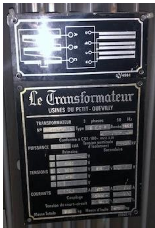
Figure 26 : Vue sur le transformateur et plaque signalétique
