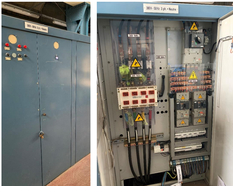
Figure 19 : TGBT 380V TNS - Vue façade et intérieure
