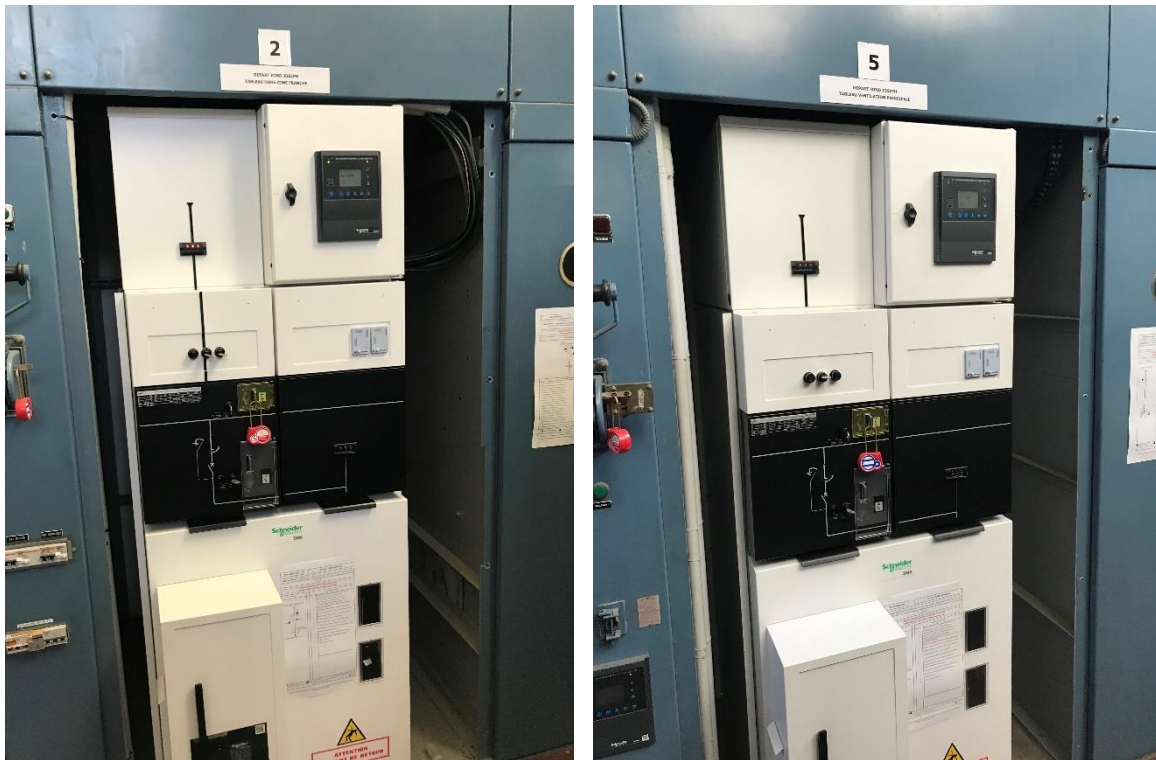
Figure 14 : HTA - Cellule 5kV - A gauche cellule n°2 - Station JOSEPH fond NZF / A droite cellule n°5 - Ventilation principale
