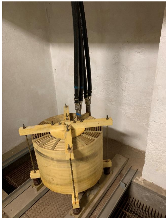
Figure 29 : Cellule n°18 - L91 Self pour moteur d'extraction
