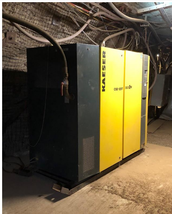
Figure 15 : Tableau de distribution air comprimé et compresseur - Recette fond Joseph
