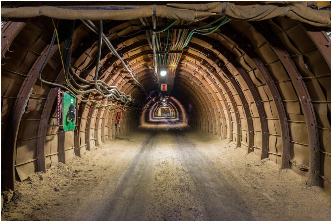
Figure 66 : Cheminement des câbles au toit de la galerie AQ0
