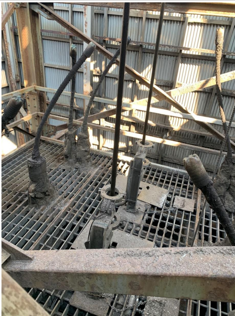
Figure 17 : Ancrages des câbles
