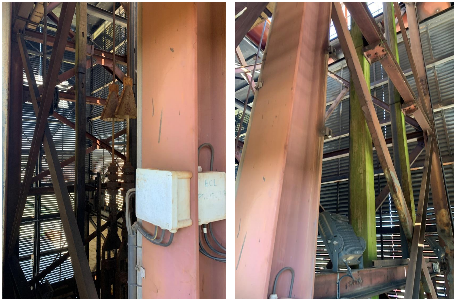
Figure 10 : Vue attelages contre-poids et guidages rigide
