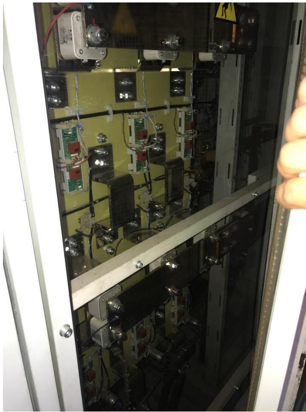
Figure 34 : Armoire AG - Pont Thyristor GEFRAN pour regulation moteur DC
