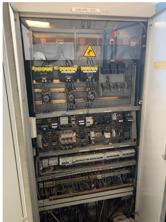
Figure 22 : TD 220V auxiliaire
