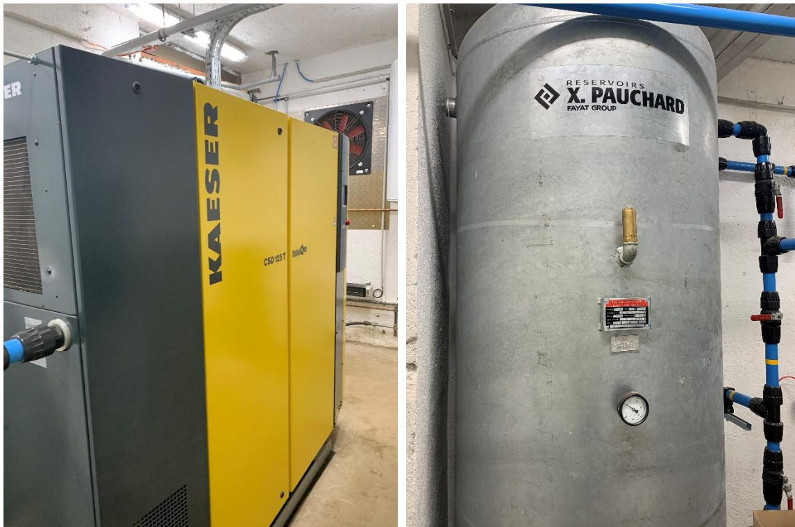
Figure 13 : Compresseur jour 75 KW et réservoir 2000L - Cave Joseph
