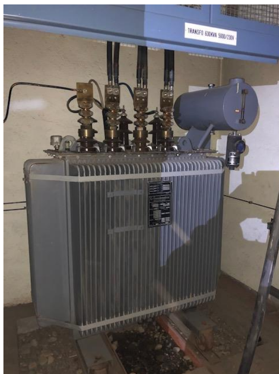
Figure 26 : Vue sur le transformateur et plaque signalétique
