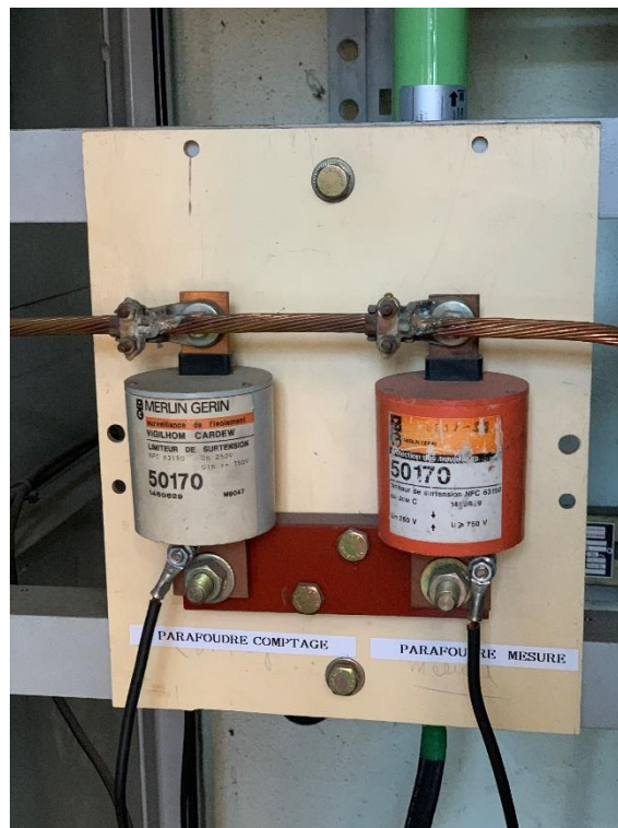
Figure 12 : HTA - Cellule n°3 – Parafoudre
