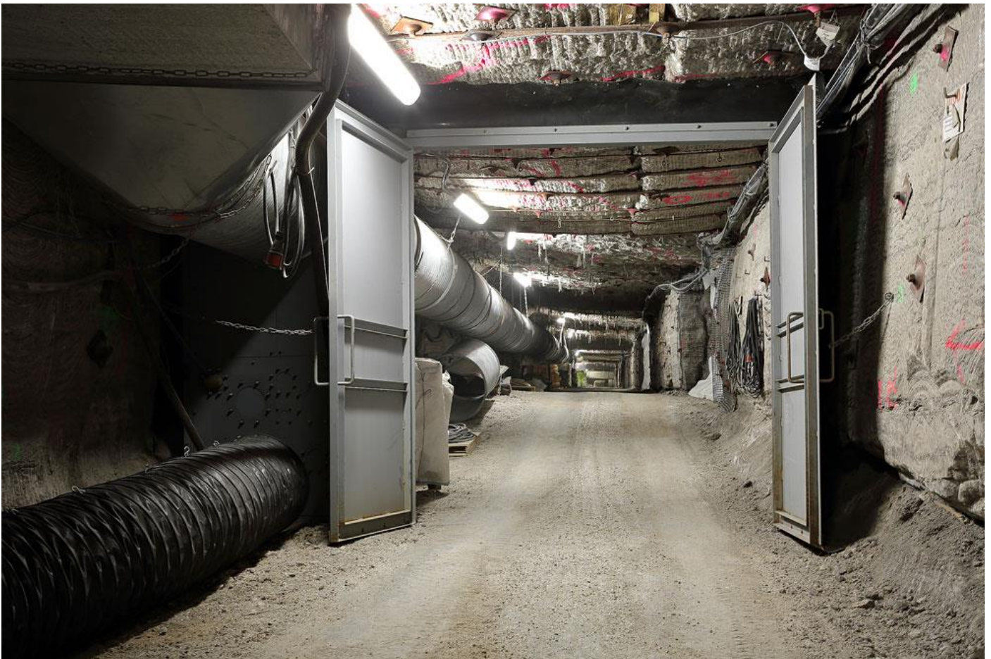
Figure 21 : Porte coupe-feu et gine d'aérage
