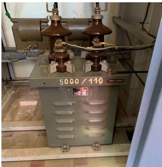
Figure 11 : HTA - Cellule n°3 - Transformateur 5kV-110V - Plaque signalétique
