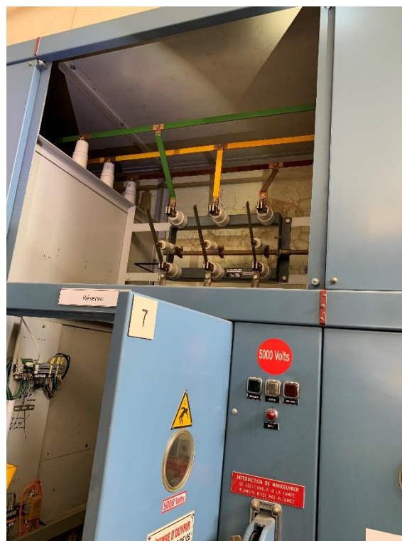
Figure 16 : HTA - Jeux de barre de cuivre 5kV
