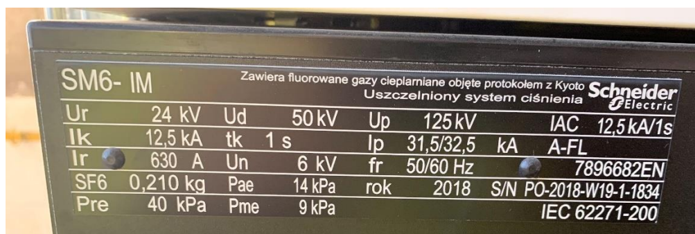
Figure 35 : Cellule n°1 - SM6 IM - Plaque signalétique
