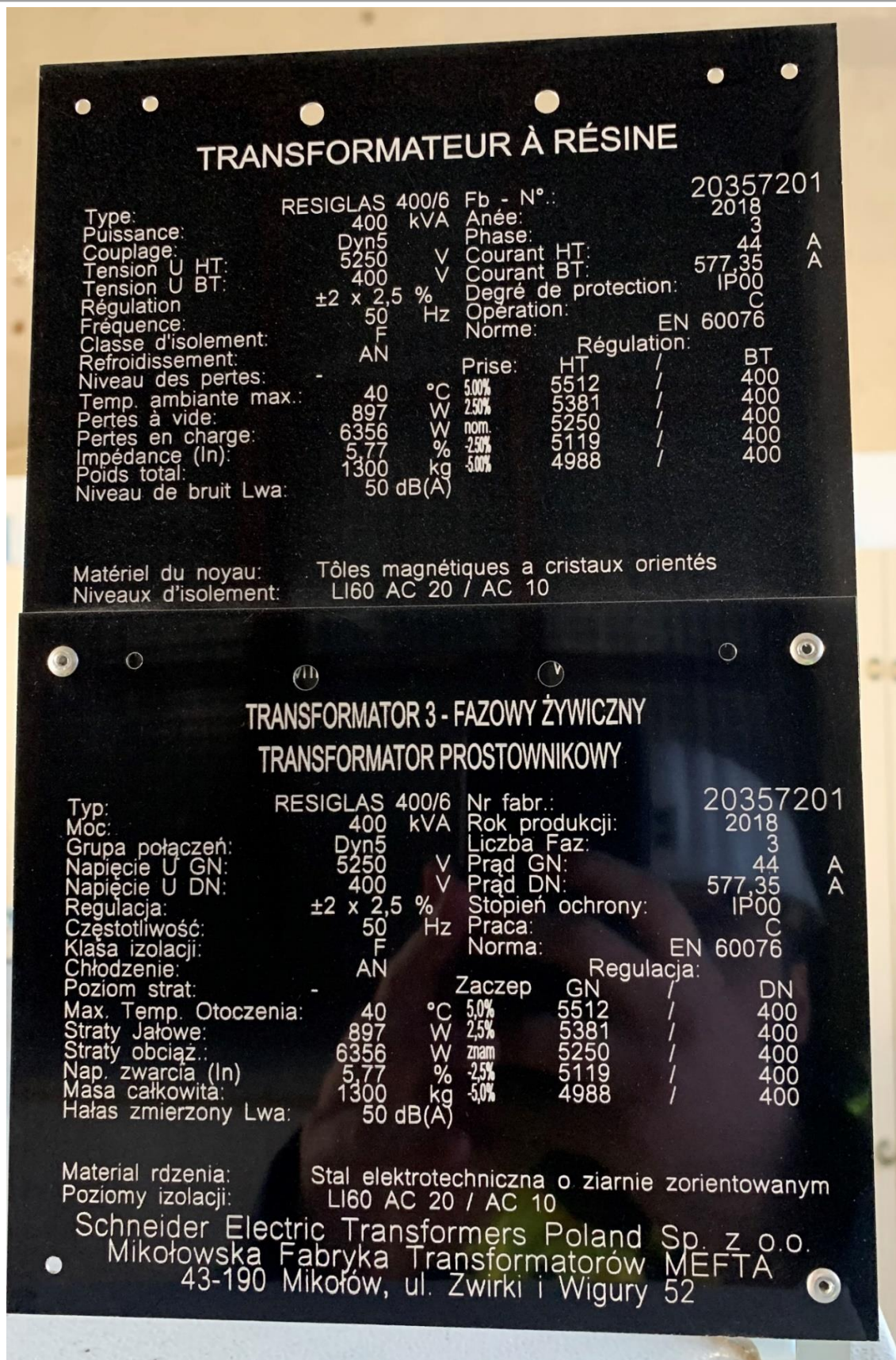
Figure 47 : Transformateur 1 - Plaque signalétique
