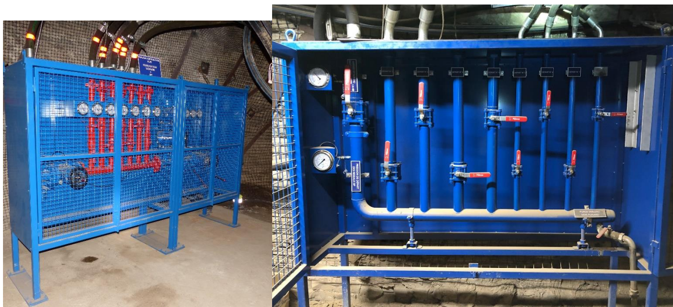
Figure 16 : Tableaux de distribution eau industrielle (10 bars) et eau incendie (50 bars)
