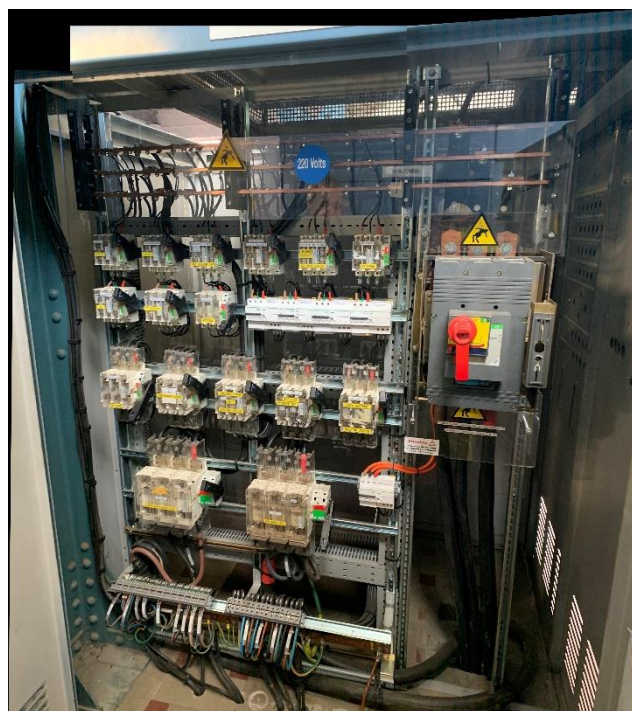
Figure 18 : TGBT 220V IT - Vue intérieure
