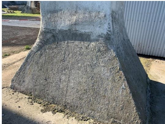
Figure 4 : Bigue de fondation puits Else
