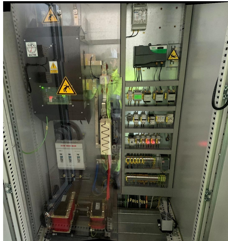
Figure 37 : Armoire de regulation Pont Thyristor + Variateur
