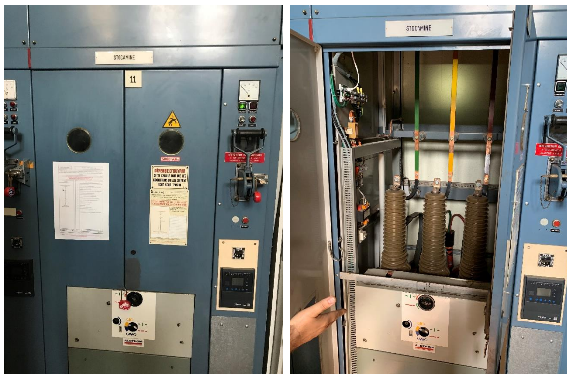
Figure 9 : HTA - Cellule 5kV n°11 - Stocamine - Vue façade et Intérieure
