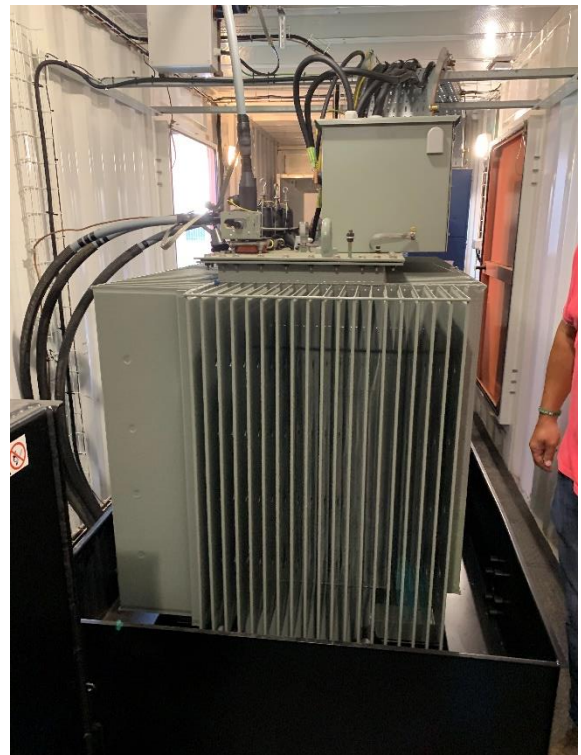
Figure 55 : Groupe électrogène - Cuve gasoil à gauche et transformateur 1250kVA 400kV-5250kV à droite
