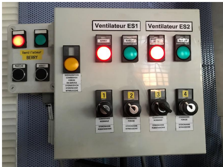
Figure 29 : Pupitre commande ventilateurs – Ecrans vidéo
