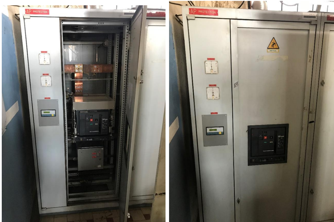
Figure 33 : Armoire AP - MasterPack - Disjoncteur de boucle Moteur DC - QF101 et protection moteur
