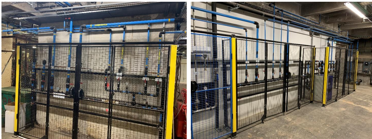
Figure 14 : Tableaux de distribution d'air comprimé - Caves bâtiments Joseph (gauche) et Else (droite)
