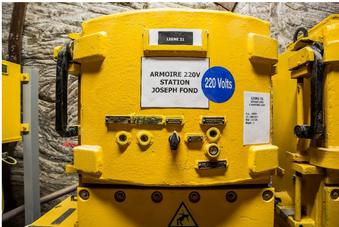
Figure 65 : Coffret électrique fond
