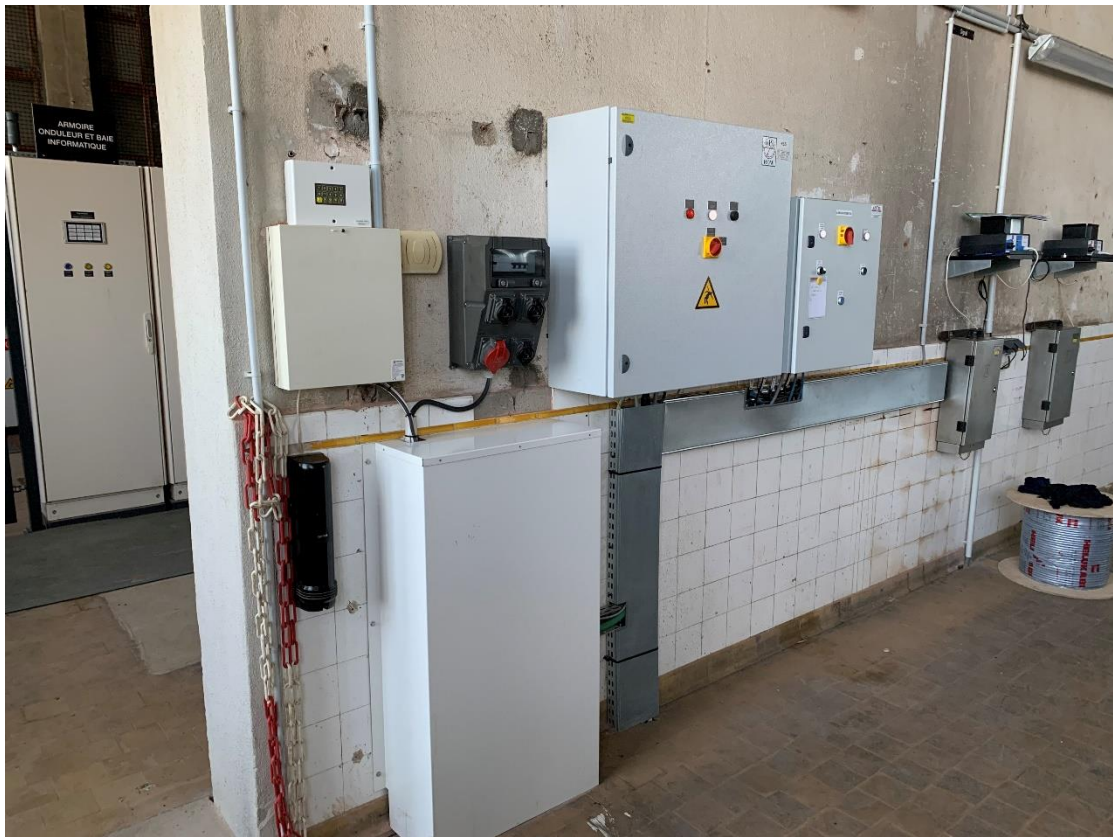
Figure 38 : Armoire SS - Alarmes et asservissement – Phonie
