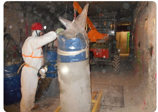
Reconditionnement d'un fût dans un sur-fût.
