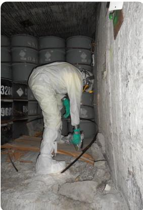
Chaque zone ayant fait l'objet de travaux de déstockage et de reconditionnement, ainsi que le matériel utilisé, font l'objet d'une décontamination puis de mesures de contrôles réalisées avec un spectromètre à fluorescence X portatif, puis, le cas échéant, d'une décontamination complémentaire.
