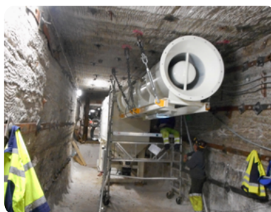
(1) Installation du dépoussiéreur.
