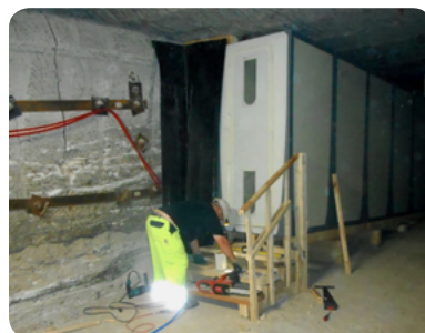
(3) Mise en place du sas de décontamination.
