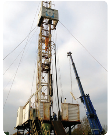
La sondeuse sur le chantier de la mine Amélie.
